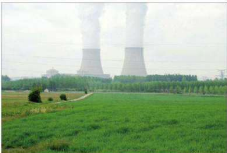
Silhouette de la centrale nucléaire, très massive et visible de très loin.
